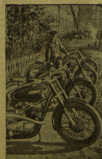
ИЖЕВСКИЙ машиностроительный завод приступил к изготовлению новых спортивных мотоциклов. Эта модель мотоцикла отличается от «ИЖ-350» более мощным мотором (16—20 лошадиных сил), зажиганием от магнето, телескопической передней вилкой и более совершенной задней подвеской. Новый мотоцикл на 20—25 килограммов легче «ИЖ-350». На нем можно развить скорость свыше 120 километров.
